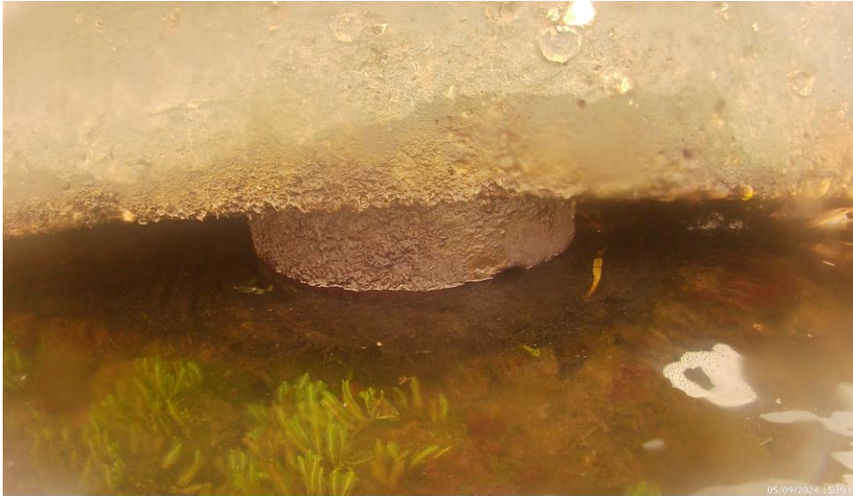
Figure 22. FOTO METRO 382 M DE LOS 847 M. Pilote
