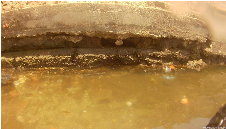
Figure 11. Foto representativa del estado del Sector 1. FOTO METRO 2 M DE LOS 847 M
