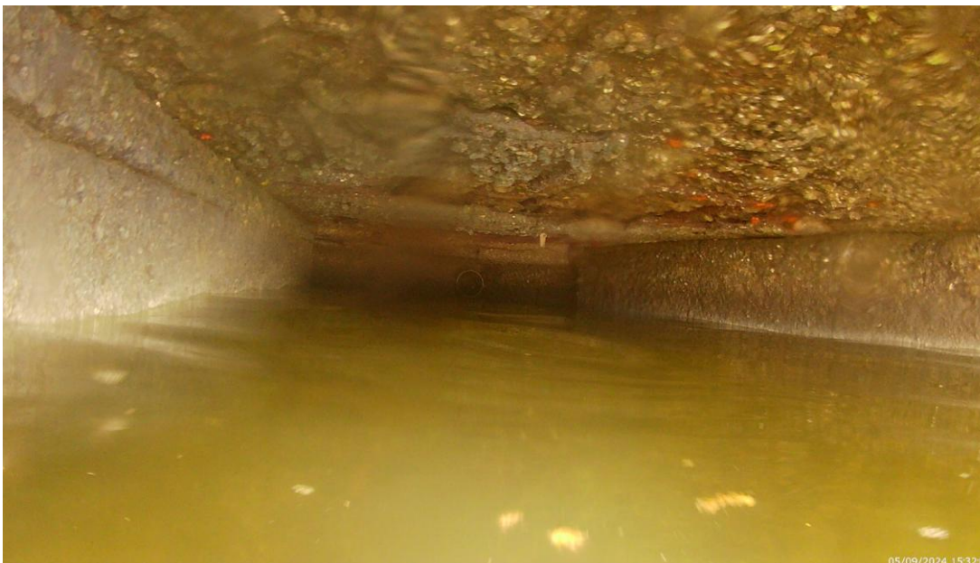
Figure 25. FOTO METRO 389 M DE LOS 847 M. Desagüe pluvial
