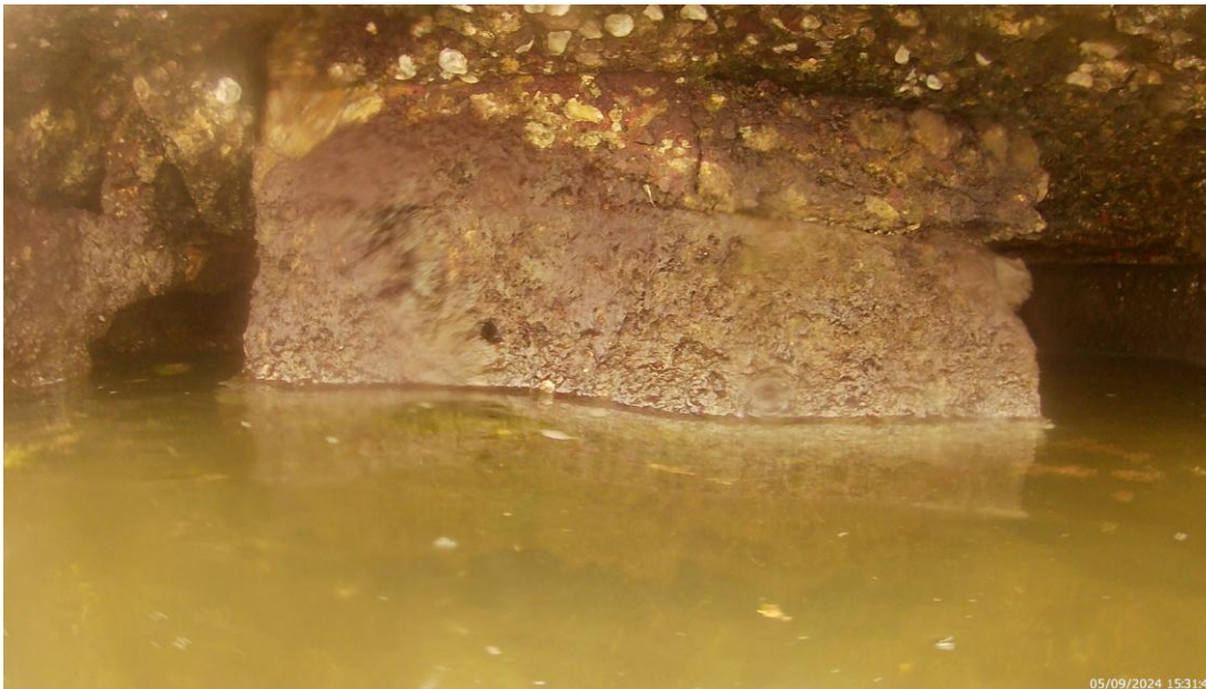
Figure 24. FOTO METRO 386 M DE LOS 847 M. Pilote
