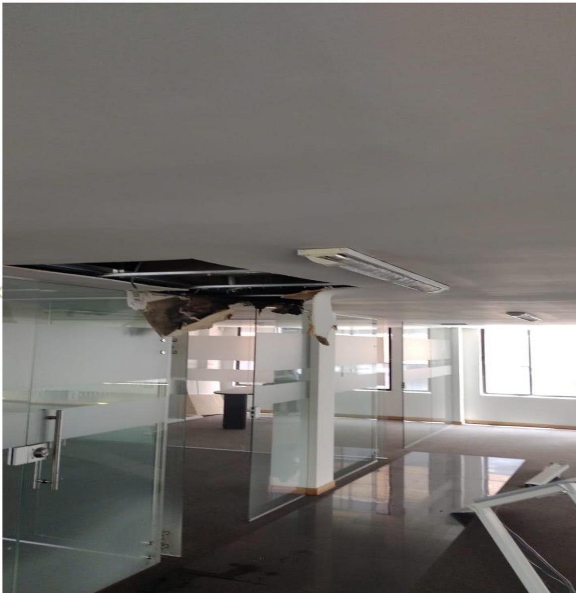
5. ESTE PUNTO SIGUE IGUAL; ACA HAY OTRA IMAGEN DE OTRA FILTRACION EN EL CUARTO PISO, CAUSADA TAMBIEN POR LAS GRIETAS DEL LEVANTAMIENTO DEL MANTO ASFALTICO EN LA TERRAZA DEL EDIFICIO, A MEDIANO PLAZO SE DEBE IMPERMEABILIZAR LA TERRAZA.
