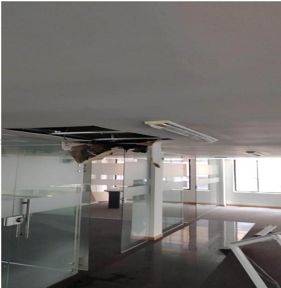
5. ESTE PUNTO SIGUE IGUAL; ACA HAY OTRA IMAGEN DE OTRA FILTRACION EN EL CUARTO PISO, CAUSADA TAMBIEN POR LAS GRIETAS DEL LEVANTAMIENTO DEL MANTO ASFALTICO EN LA TERRAZA DEL EDIFICIO, A CORTO PLAZO SE DEBE IMPERMEABILIZAR LA TERRAZA.
