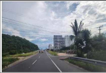
VÍA PRINCIPAL DE ACCESO
