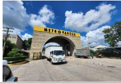
FACHADA PARQUE INDUSTRIAL
