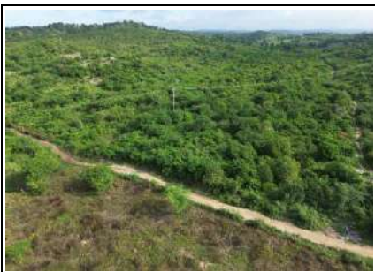
VISTA GENERAL LOTE Y LINEA ELECTRICA
