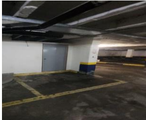
GARAJE No 28 SIN DEMARCAR
